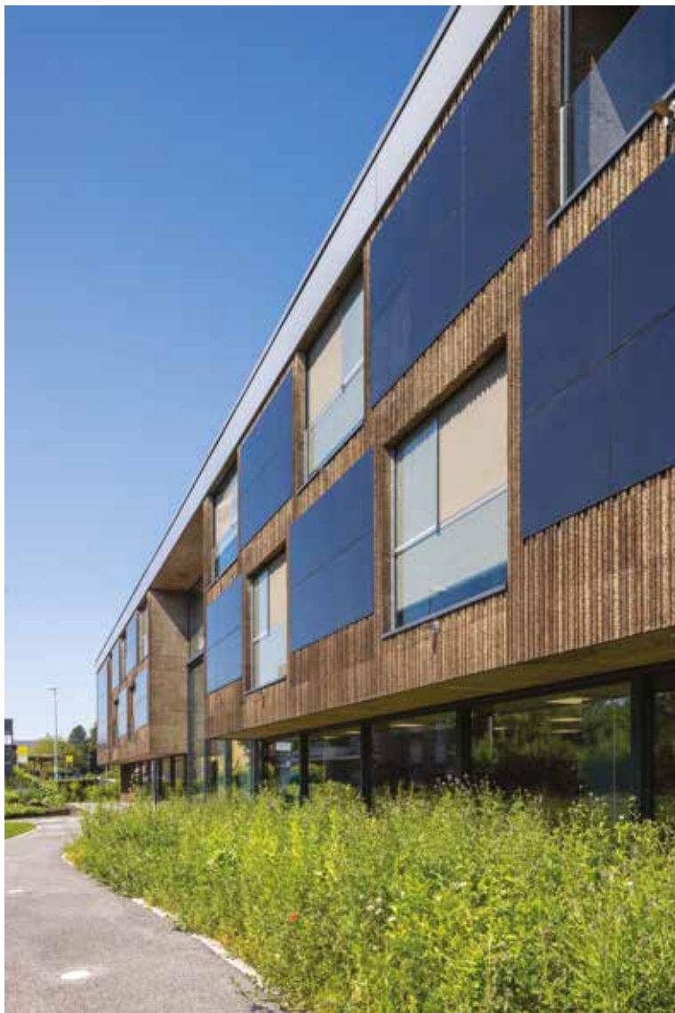
Lo Scudo di Stabio, fotovoltaico in facciata. (Ph.: Mengani)
