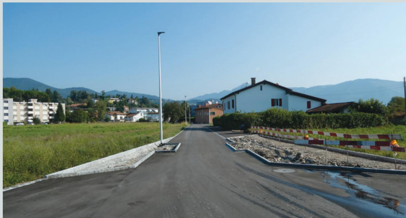
L'intero rifacimento dell'asfalto e la posa di nuove bordure di delimitazione, sono stati completati dal risanamento e dal potenziamento delle sottostrutture quali la canalizzazione con le griglie per una corretta evacuazione delle acque meteoriche, l'acqua potabile e l'illuminazione stradale.
