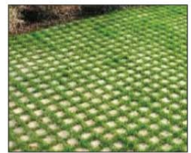
② Pavimentazione drenante parcheggio
